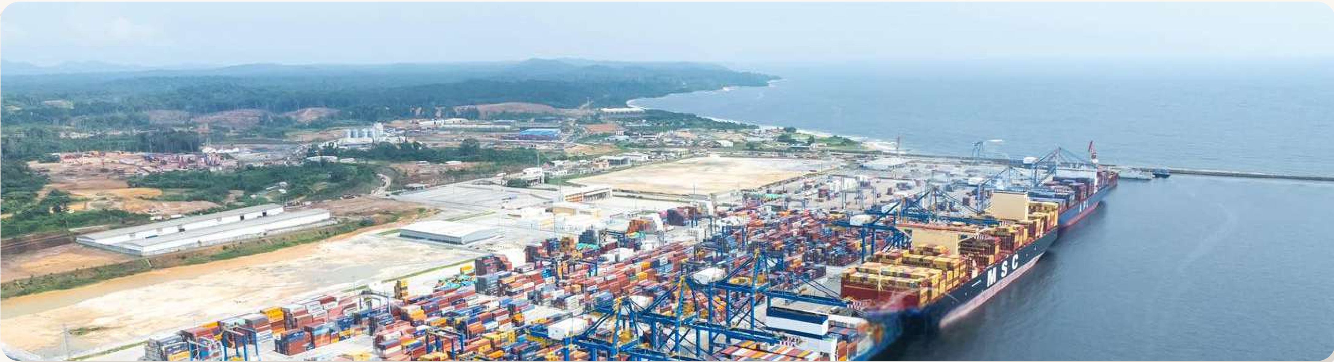
Visuel d'ouverture: Port Autonome de Kribi et flux de transit vers l'hinterland
